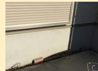
建物基礎部の拡大写真
